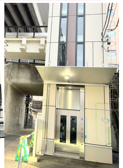
東十条駅南口階段下エレベーター(下)
